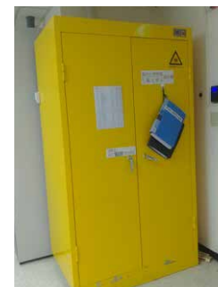
存放列管毒化物的防爆抽氣櫃
